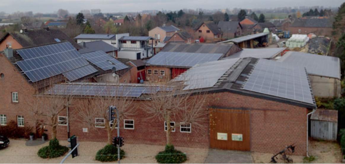
Auf den Dächern des Hofes der Familie Frenken in Heinsberg-Unterbruch wurde die 1 000. Solaranlage von Tholen Elektrotechnik installiert.
